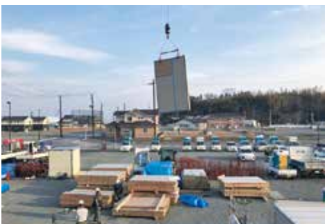
富岡社屋、建て方の様子①
