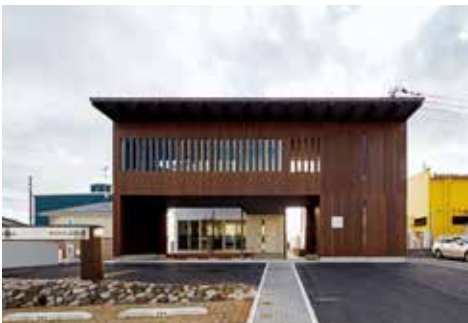
郡山社屋外観 約11mスパンのピロティを持ち、2階は縦ログ壁に囲まれた会議室である。準防火地域ながら、縦ログの準耐火性能の大臣認定を活用することで内外木表しとなっている 郡山社屋内観 富岡の森から切り出したモミ材を組み合わせて8mスパンの調気梁による一室空間の執務室が生まれた
