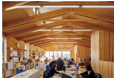
郡山社屋外観 約11mスパンのピロティを持ち、2階は縦ログ壁に囲まれた会議室である。準防火地域ながら、縦ログの準耐火性能の大臣認定を活用することで内外木表しとなっている 郡山社屋内観 富岡の森から切り出したモミ材を組み合わせて8mスパンの調気梁による一室空間の執務室が生まれた
