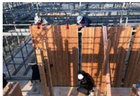
富岡社屋、建て方の様子②
