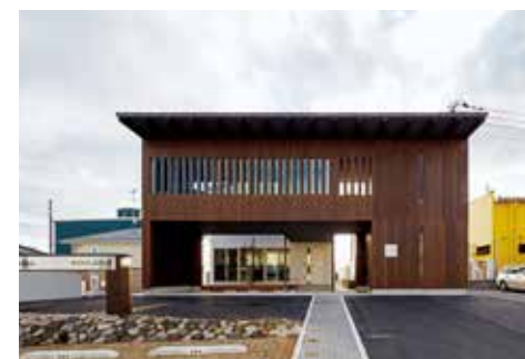
郡山社屋外観 約11mスパンのピロティを持ち、2階は縦ログ壁に囲まれた会議室である。準防火地域ながら、縦ログの準耐火性能の大臣認定を活用することで内外木表となっている
