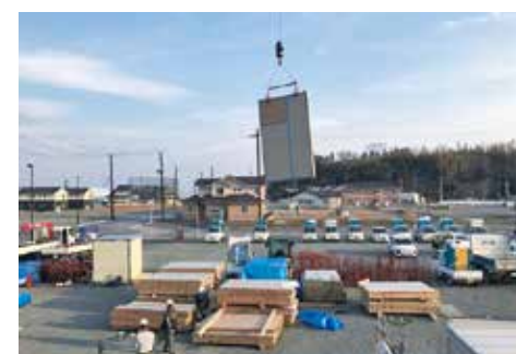
富岡社屋、建て方の様子①
