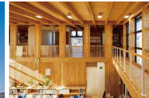
2階桁上にはヒノキ化粧合板を用い、仕上げ材ともしている
